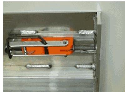
**Perno retractable:** La combinación del sistema Set-n-Lok con estos pernos retractables es la solución óptima para paredes altas ya que asegura la formaleta en su posición con mucha rapidez y con menos herrajes requeridos. Las formaletas se aseguran con sólo juntarlas, sólo se necesita ir a dos posiciones para lograr un cierre seguro.
